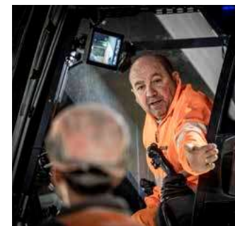
Maschinist Antonio Bernardo erstellt Pfähle.
