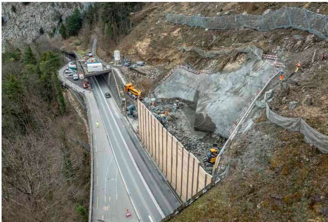
Im Abschnitt Buggi erstellte die GSTB eine Schutzwand und im Anschluss Sicherungsmassnahmen.
