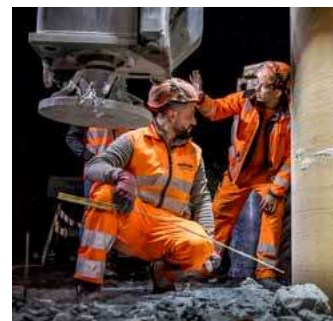
Luigi Lombardi (links) und Louis Schilling (rechts): Lagekontrolle Pfahl
