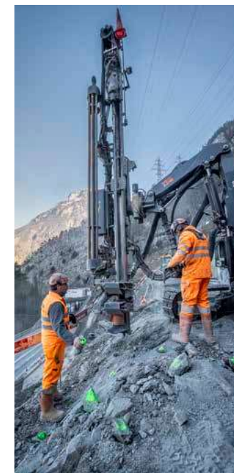
Bohren der Sprenglöcher am Voreinschnitt Buggi.
