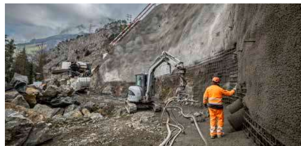
Das GSTB-Team bohrte Sprenglöcher für den Aushub und erstellte eine 1200 m² grosse Nagelwand.
