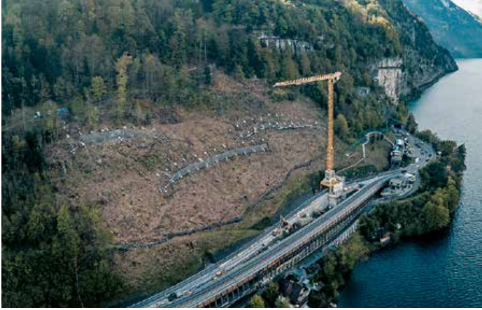
Total 196 m Steinschlagschutzwerke beim Bauplatz «Ort»
