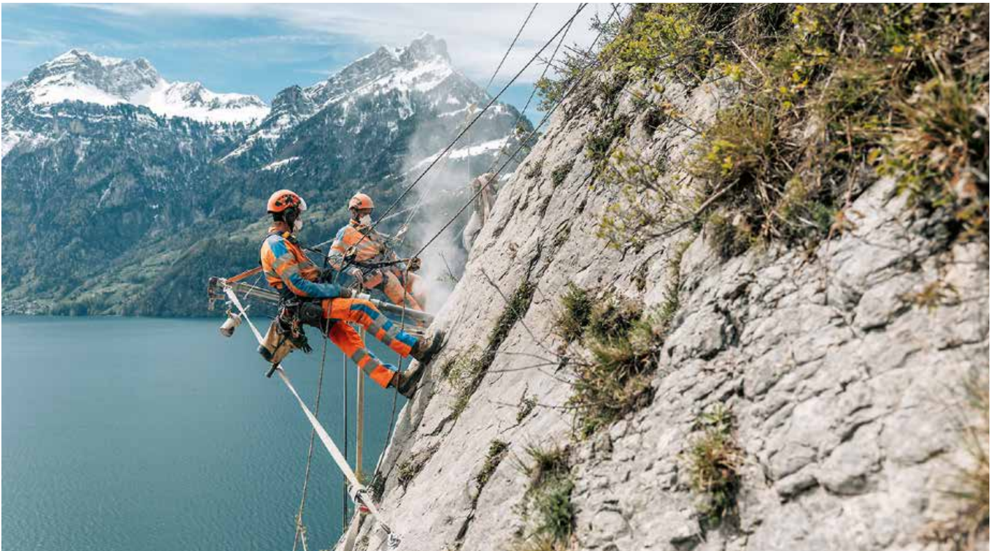
Anker bohren mit der Mounty-Leichtbohrlafette
