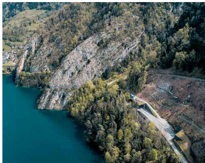
Steinschlagschutzwerke am Bauplatz «Buggi»
